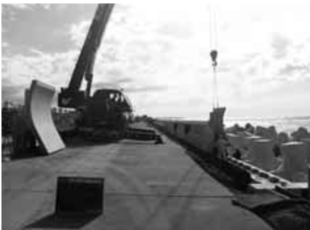
波返しブロック設置状況
