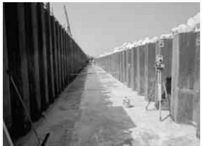
改良及びコンクリート基礎
