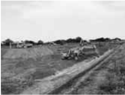
掘削 法面整形 土砂積込
