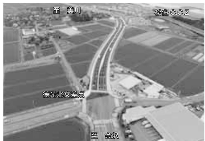
写真 - 4 整備状況 (徳光北交差点から小川町望む)
