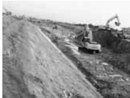
掘削 土砂積込
