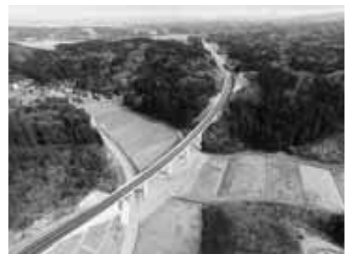
写真-3 完成した細坪町～曾宇町間
