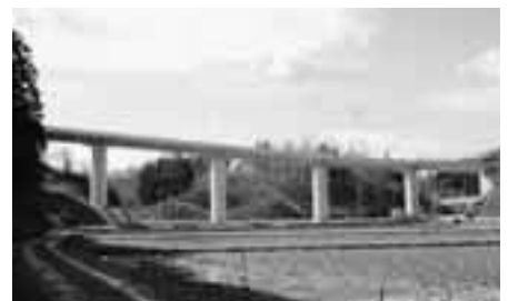
写真-1 細坪大橋
