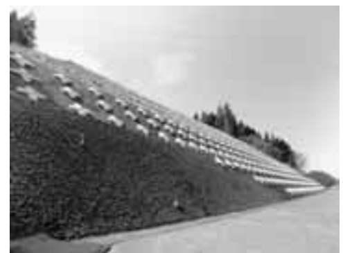
写真-2 グラウンドアンカーによる法面对策
