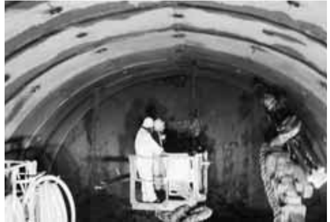
ドリルジャンボによる水抜き
