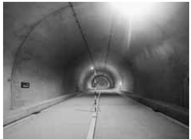
工区境 (No.166+16.0)～和田側坑口を望む
