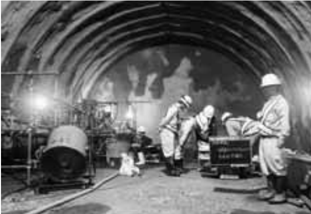
水平ボーリング前方探査
