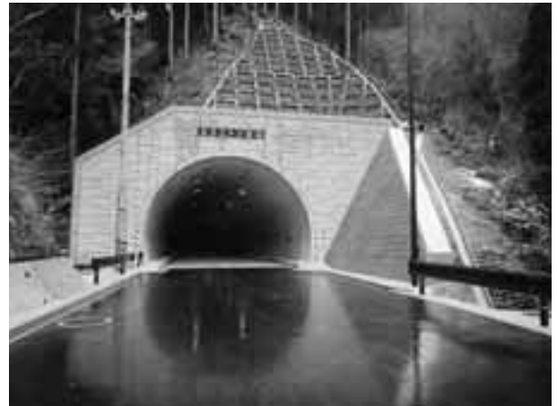
和田側坑口 (No.202+2.0)
