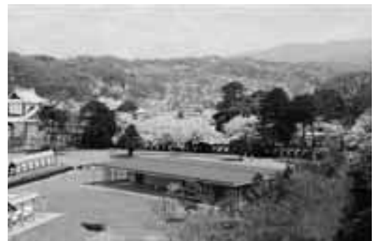
鶴の丸休憩館全景
