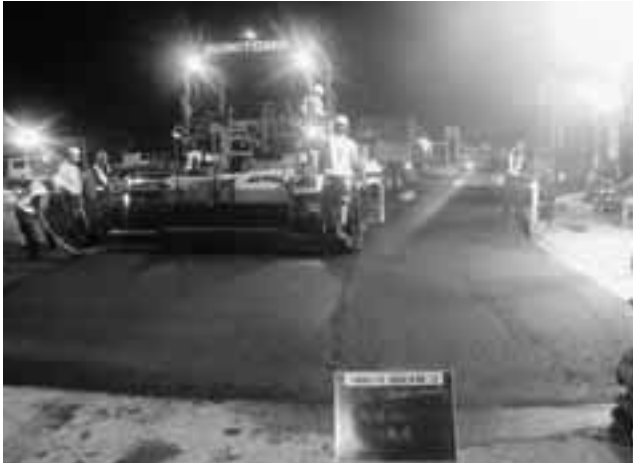
舗装工：施工状況 (交差点内の施工ジョイントを少なくする為、ホットジョイント(2台)での施工)
