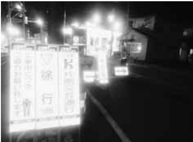
安全対策：カプセルブリズム型高輝度反射シート工事看板の使用 (NETIS登録番号 HR-07005V)
