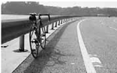
写真 - 6 路面標示
