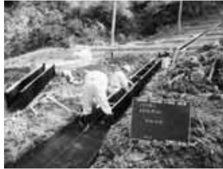
角型U字溝据付状況
