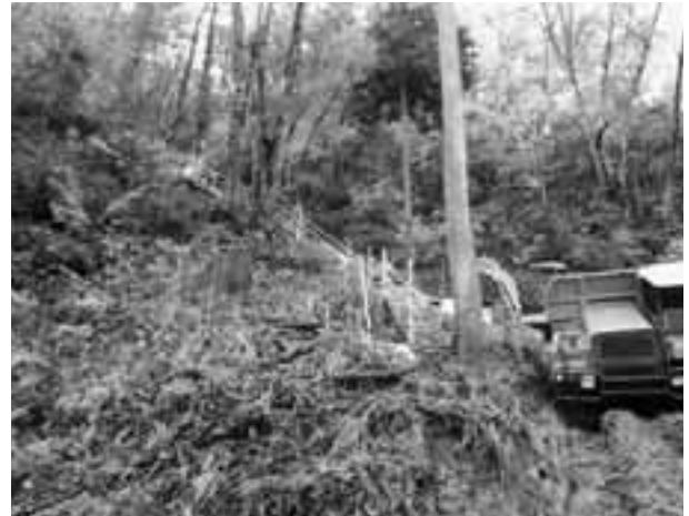
昇降階段設置
