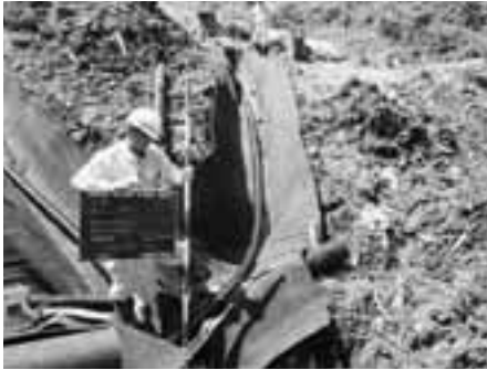
暗渠工設置状況
