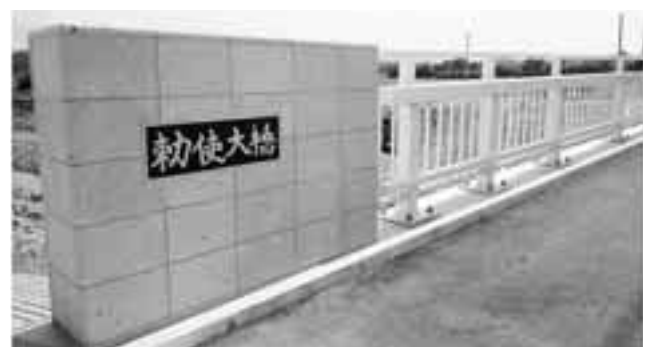
写真 - 4 勅使大橋における親柱と高欄
