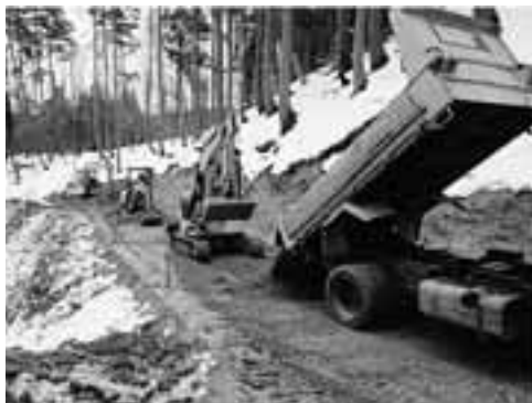
冬季の施工状況
