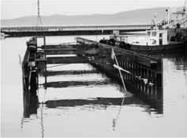
矢板変位防止用仮切梁設置（ジャッキ付）
