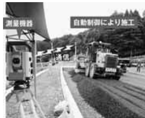
写真 - 2 ICT 施工による舗装工
