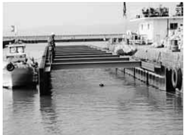
ワイヤーモッコ使用による中詰石投入（矢板防食部保護対策）
