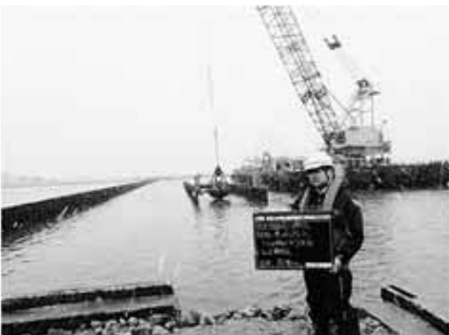
グラブバケツ（1.0m 3 級）使用による投入
