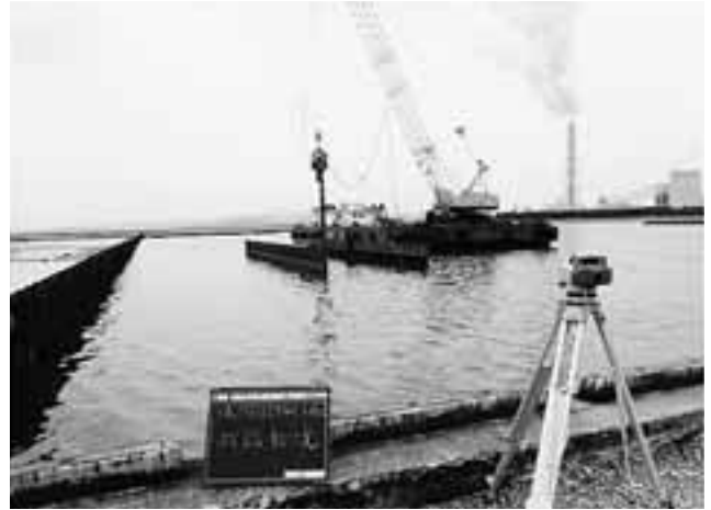
鋼矢板打設状況
