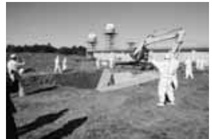
埋却処分状況
