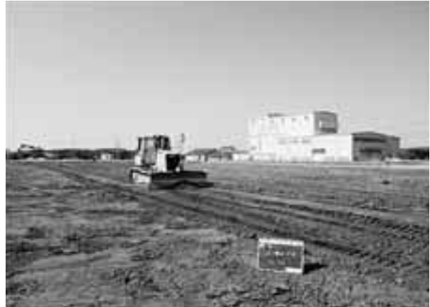
均平作業状況
