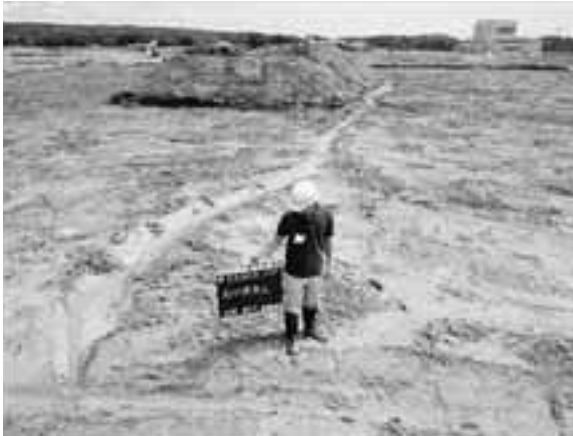
水切り溝の施工
