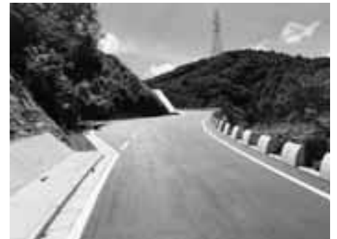
写真-1 完成した道路(石川県側県境付近)
