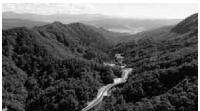
写真 - 8 県境部（石川県側から福井県側を望む）
