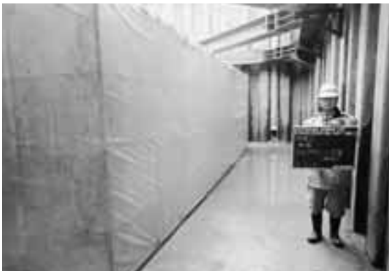
気泡緩衝シート養生
