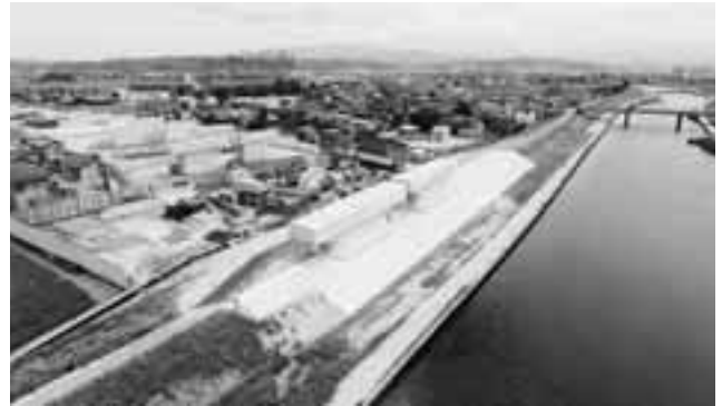
工事完成写真（浅野川下流側より上流側を望む）
