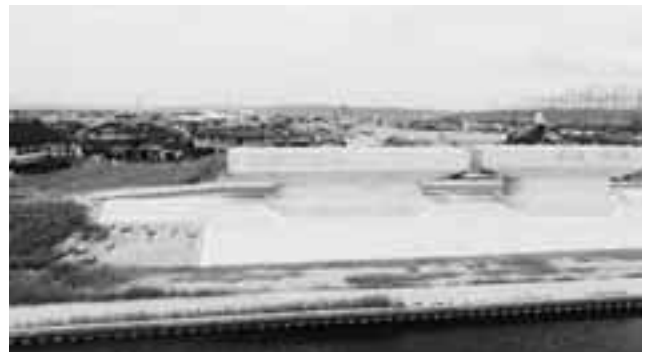
工事完成写真（起点側より終点側を望む）
