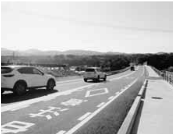
写真 - 3 現在の利用状況
