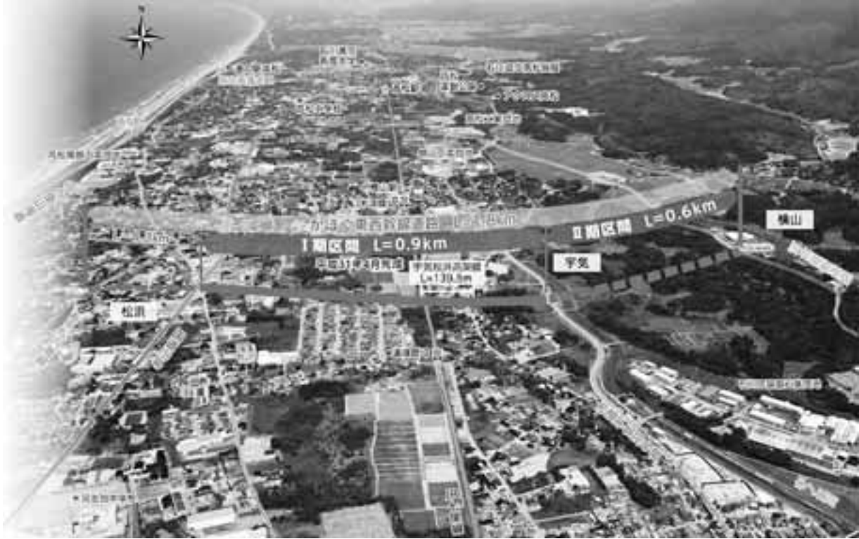
写真 - 2 かほく東西幹線道路の全景写真
