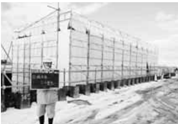
全天候型仮囲い養生
