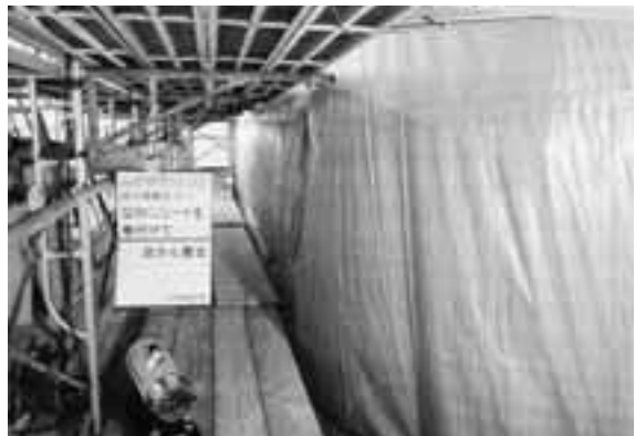
型枠側面封かん養生
