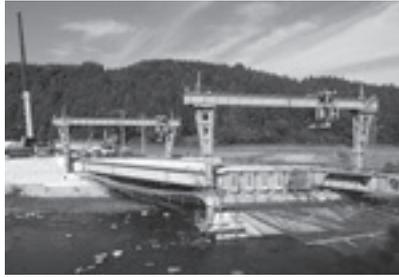
A1～P1径間架設桁架設工法
