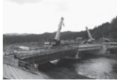
P1～A2径間トラッククレーン併用架設工法
