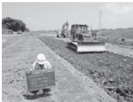
2層目 敷均し転圧状況
