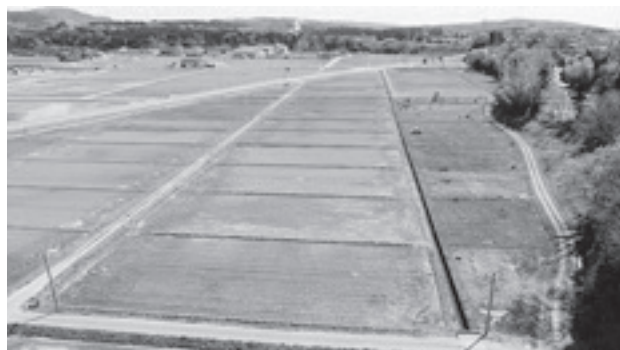
工事着手前写真
