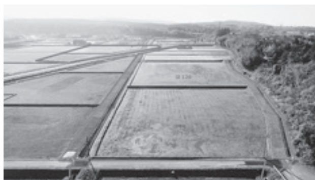
工事完成写真 は127～122
