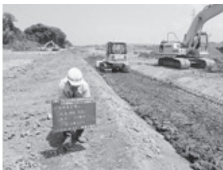
1層目 敷均し転圧状況
