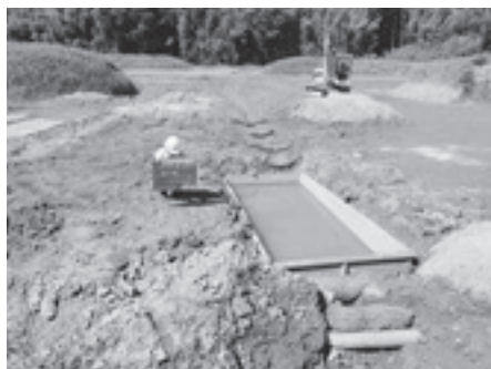
土水路及び沈砂池ろ過材設置
