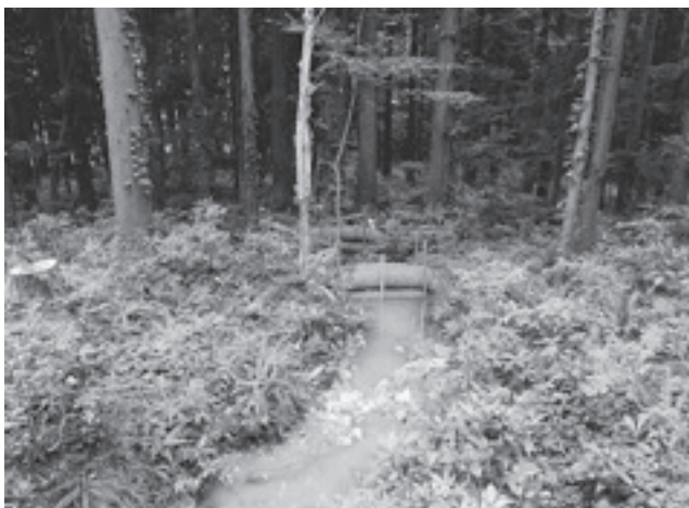
バイオフィルター設置
