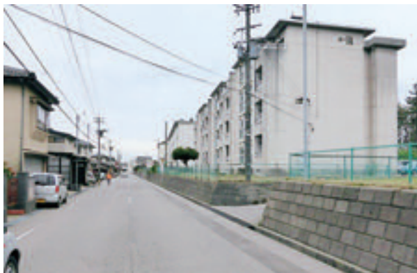
写真-1 既存住棟と前面道路の状況
