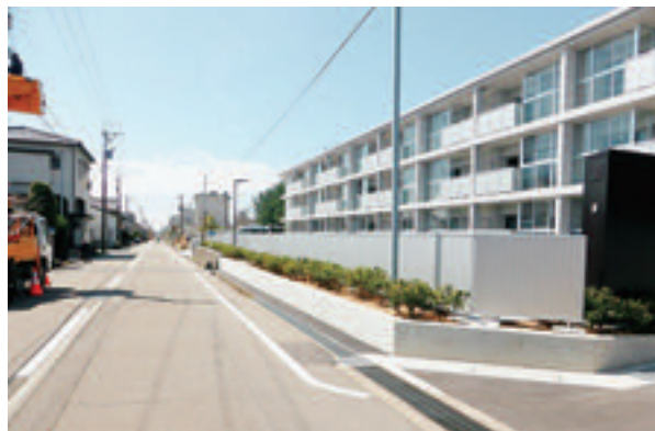
写真-2 今回完成箇所（1号棟A）
