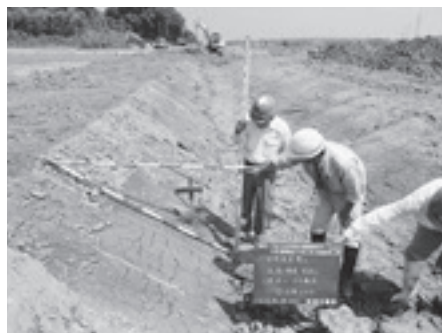
基盤巻き出し 丁張確認
