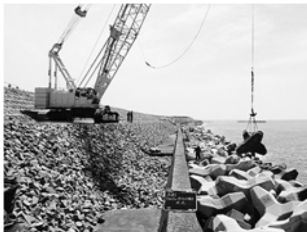
消波ブロックの据付状況
