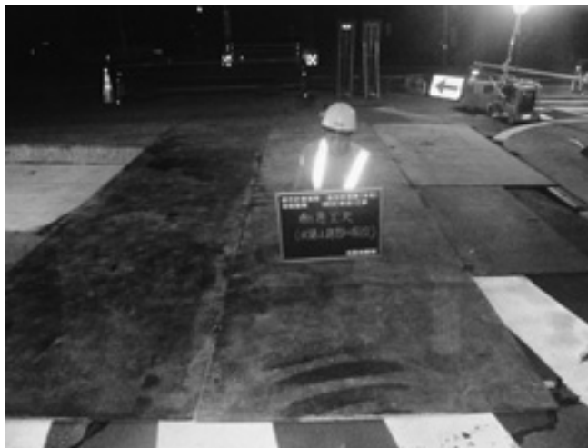
工事時間外の市道部は通行止にならないように、仮設の橋を設置して解放した。
