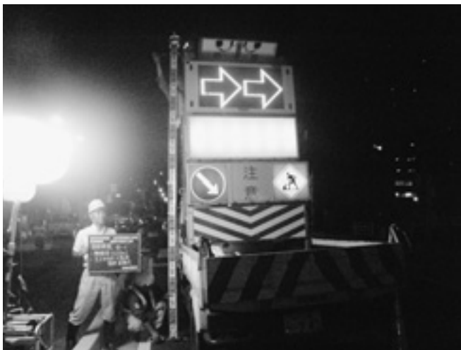
交通が多い夜間工事のため、遠くから視認しやすい大型の標識車を使用した。
