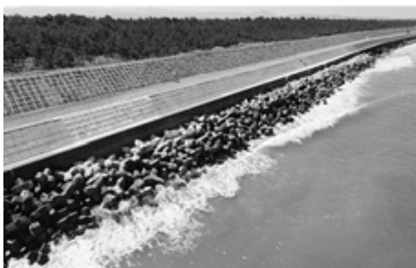
完成時の消波ブロック及び背面構造物
