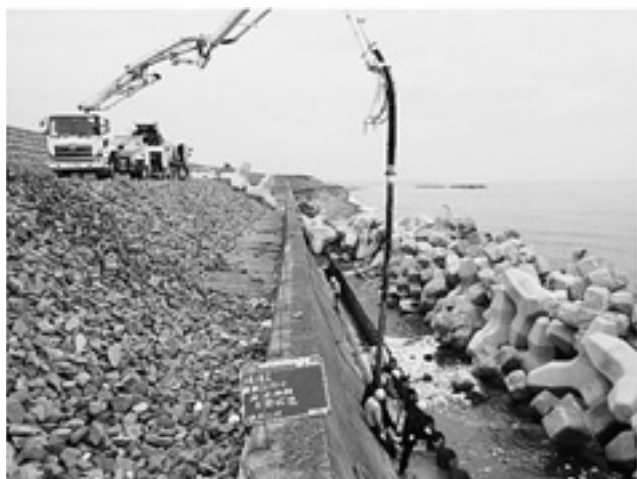
根継間詰コンクリート打設状況
