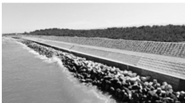
完成時の消波ブロックと背面構造物
