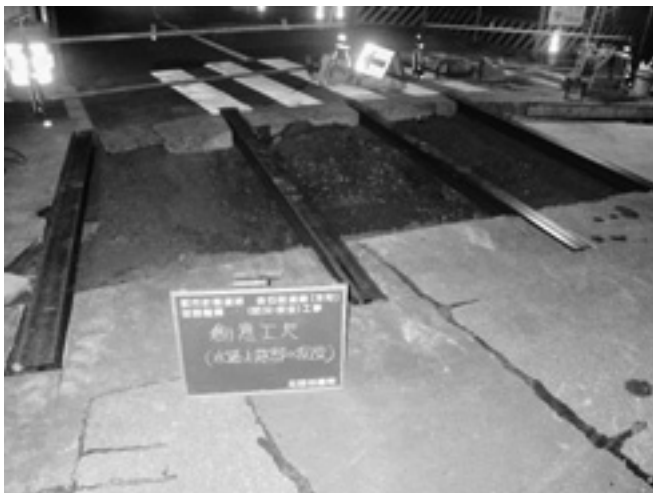
工事時間外の市道部は通行止にならないように、仮設の橋を設置して解放した。
