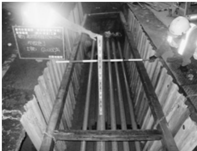
電線管の配管は、既設の埋設管や支障物を避けるように、常に先を考え割付けし施工を行った。
