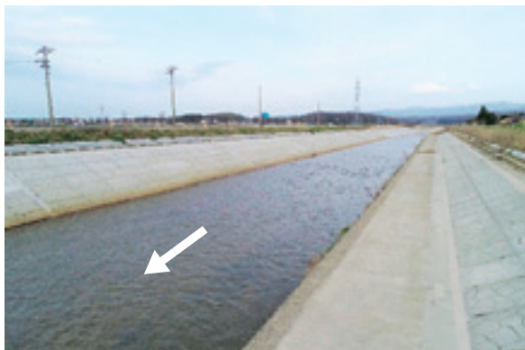
写真-1 完成状況（能美市佐野町地内）
