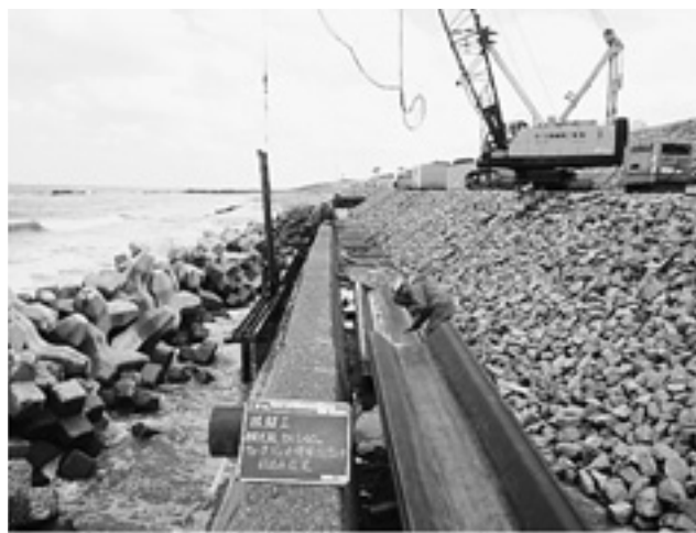
根継鋼矢板の打込み状況
