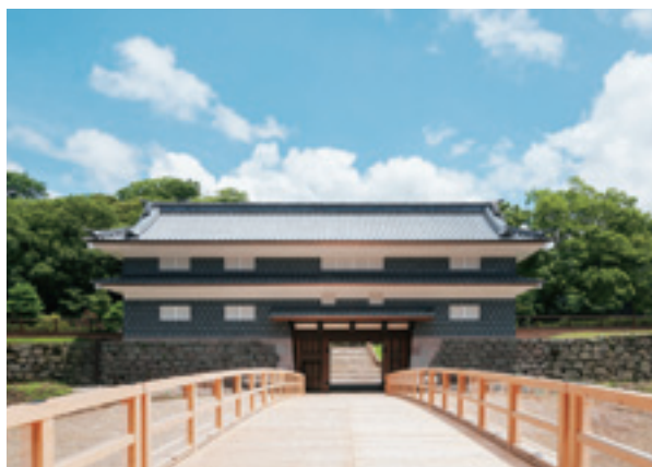
写真ー1 鼠多門・鼠多門橋完成写真
