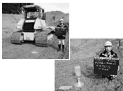
試験盛土の実施 (転圧状況、現場密度試験)
