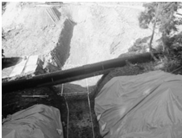
掘削完了・回水状況
