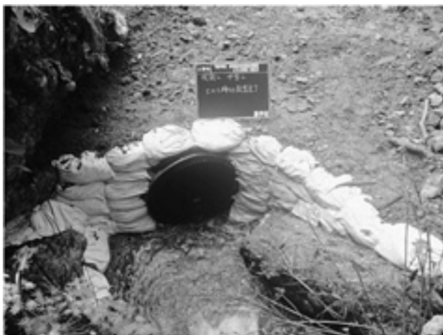
土のう締切工
