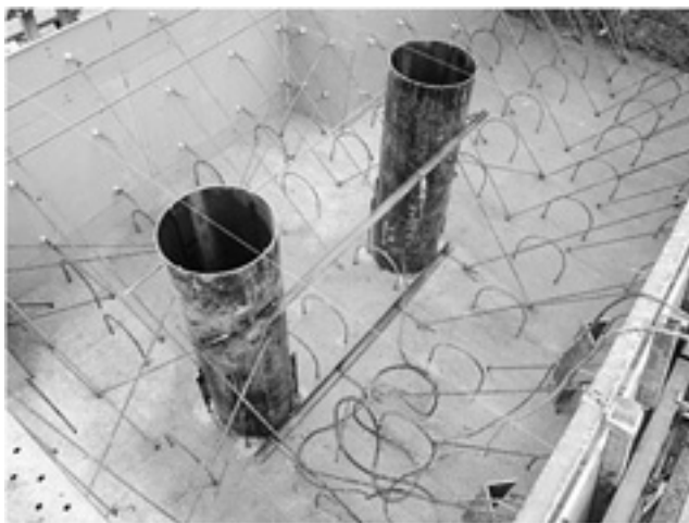
流木捕捉工・さや管設置
