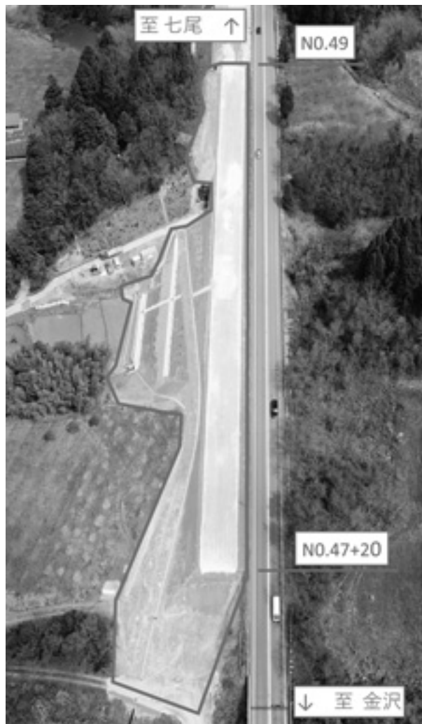
完成写真 盛土区間
