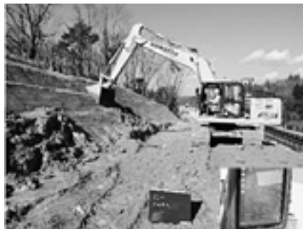
MC機による切土施工 (法面整形)
