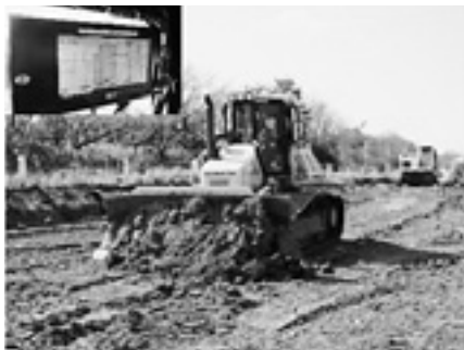
GNSSによる管理ブロック 四隅一点判定方法にて 締固め管理を実施
