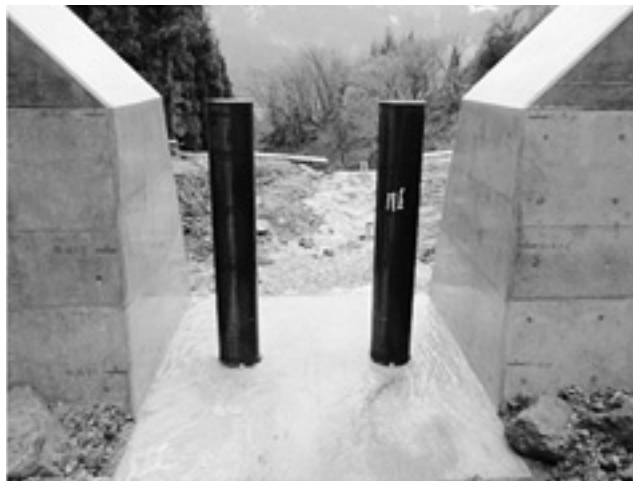
流木捕捉工・鋼管柱設置
