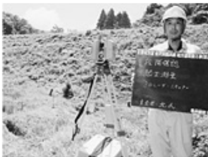
3D レーザースキャナーによる起工測量
