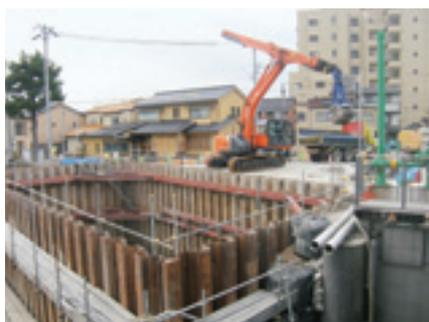
A1橋台土留工全景、クラムシェルによる掘削状況
