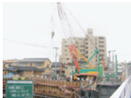
120tクローラクレーンによる旧橋ブロック搬出状況
