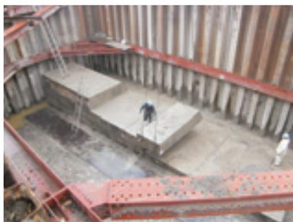
切断した旧橋ブロックの吊り上げ状況
