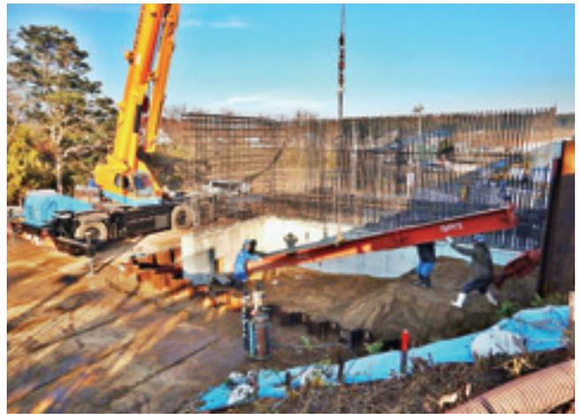
1段目斜切梁撤去作業
