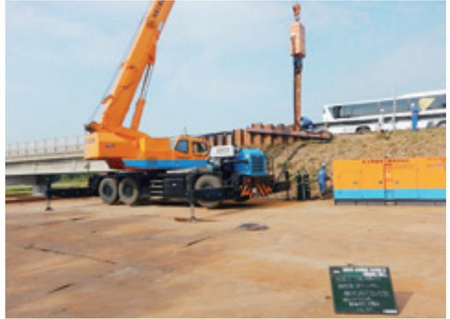
近接作業員配置による鋼矢板打込み作業
