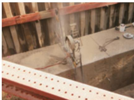
ワイヤーソーによる旧橋切断状況
