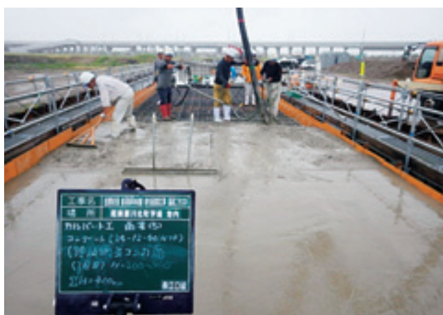
コンクリート打設
