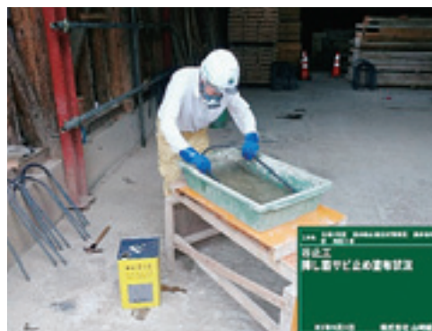
挿し筋の錆止め塗布
