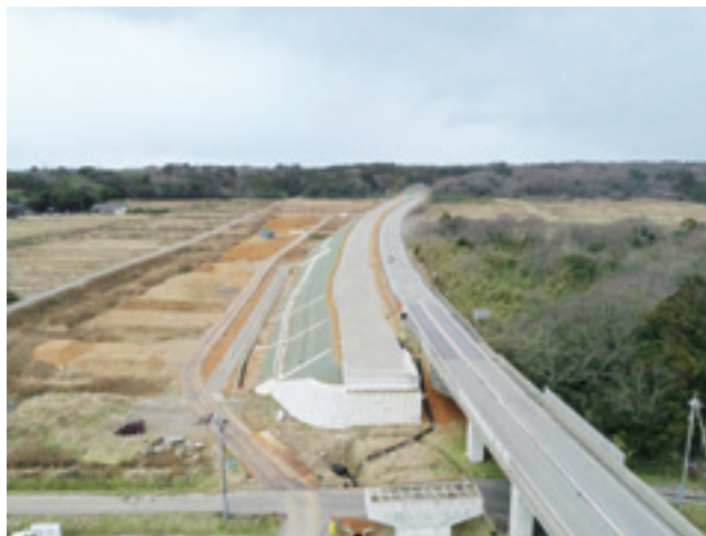
写真-4 4車線化工事中区間の状況 (羽咋市寺家町地内)
