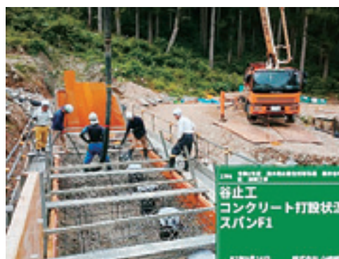
コンクリート打設状況
