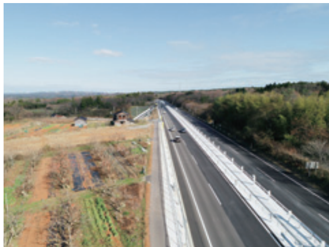
写真-3 今回完成した4車線区間の状況 (羽咋市上中山町地内)
