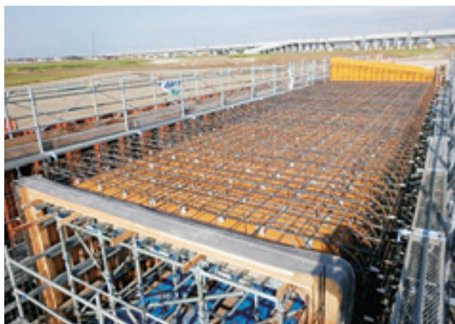
鉄筋組立状況
