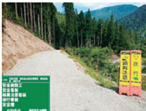
仮設道路の整備及び安全柵設置
