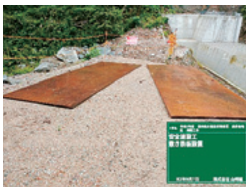
路肩保護の為に敷き鉄板設置
