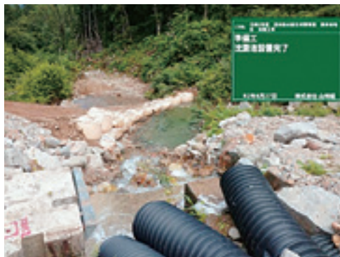
現場下流での沈殿池設置
