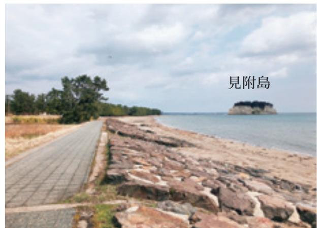
写真-2 緩傾斜護岸工
