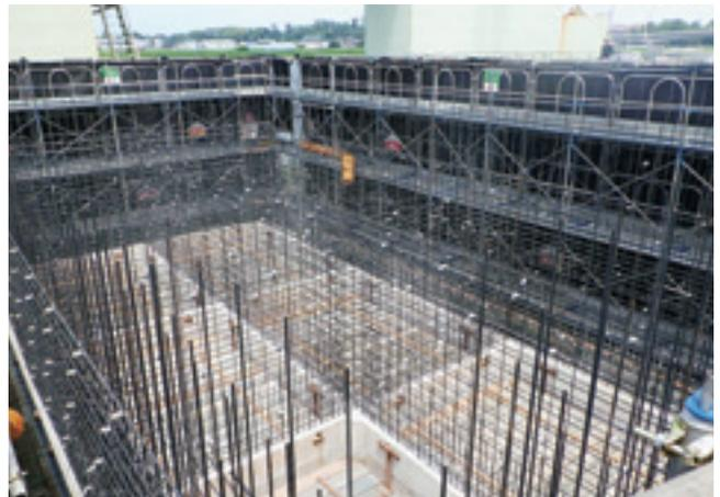
ケーソン製作鉄筋組立状況
