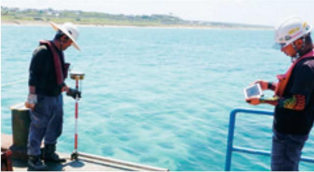
コンクリートブロック据付時 GPS使用・施工位置確認
