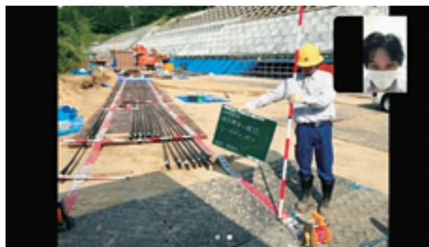
写真7 遠隔臨場による確認状況
