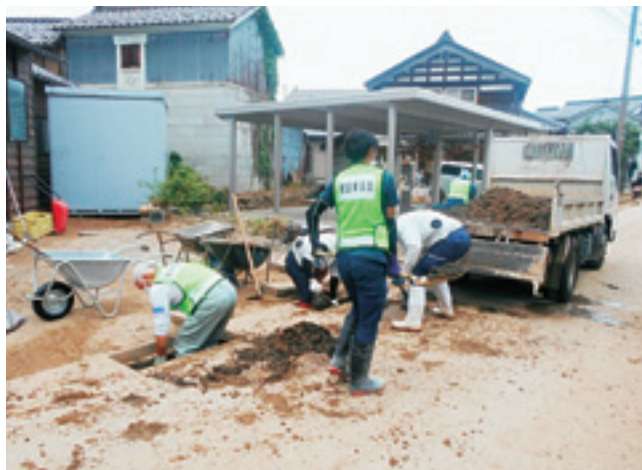
側溝の土砂除去(小松市中海町)
