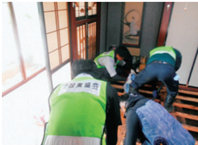
家屋床下の土砂の除去(白山市三坂町)
