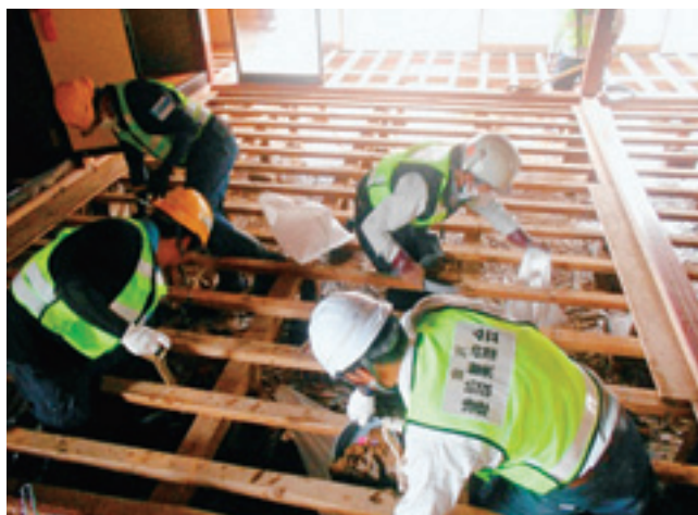
家屋床下の土砂除去(小松市中海町)
