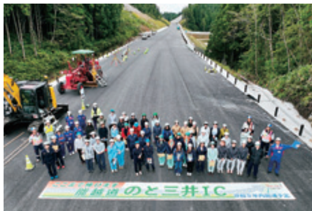
能越自動車道(輪島道路)
