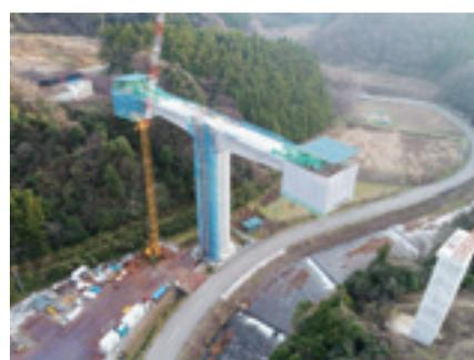
張り出し架設工法（移動作業車の防護）
