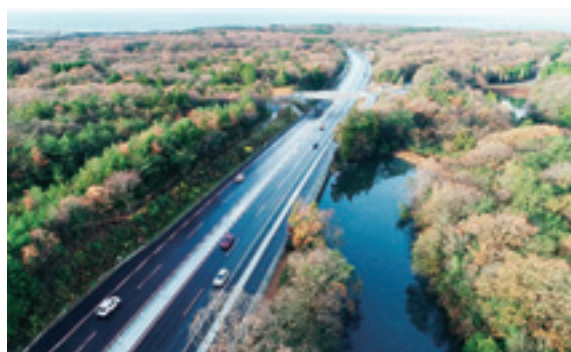
写真-3 今回完成した4車線区間の状況 (羽咋市柳田町地内)
