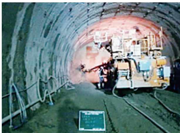
水抜き工施工
