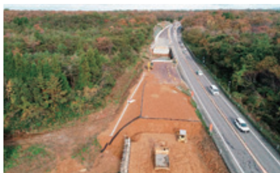
写真-4 4車線化整備状況 (羽咋市寺家町地内)
