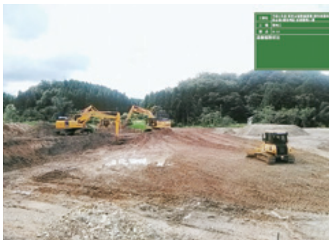
石礫部 基盤整地状況
